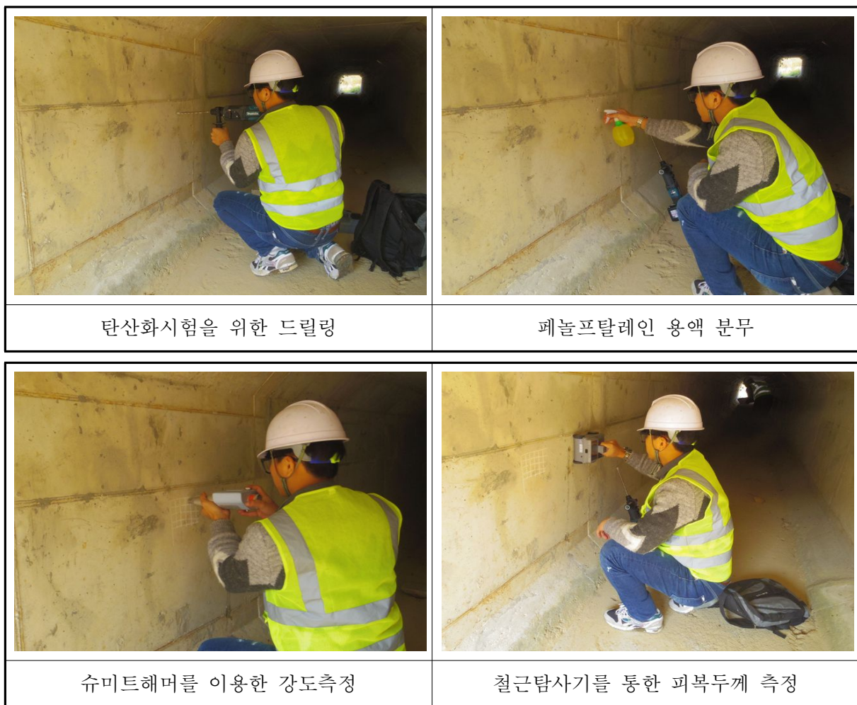
【사진 Ⅱ.3-3】 시험 및 측정 전경
